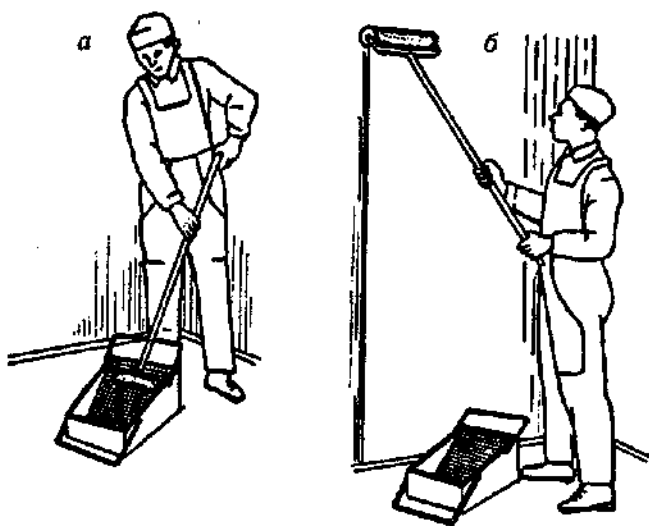
Рис. 123. Техника работы валиком с длинной ручкой: а — набор краски из ванночки; б — окраска стены.
